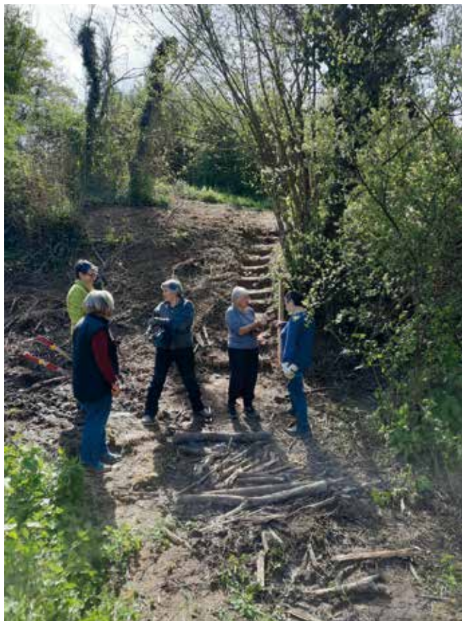
Réalisation de l'escalier situé route de Sainte-Rame. Signalétique fabriquée et posée par les bénévoles.
