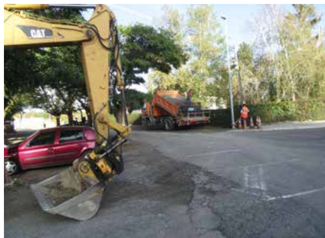
Travaux sur le parking de la piscine.
